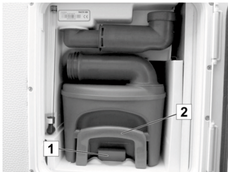
Abb. 154: Fäkaliertank im Entsorgungsschacht
