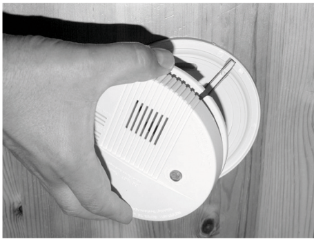
Abb. 114: Gehäuse abnehmen
