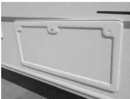
Abb. 29: Wohnaufbau, Servicefach außen
