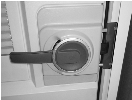
Abb. 20: Türschloss geschlossen, aber ungesichert
