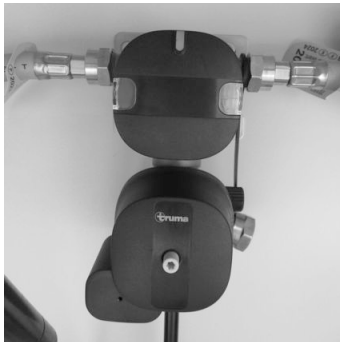
Abb. 83: Gasversorgung (mit Eis-Ex und Fernanzeige)
