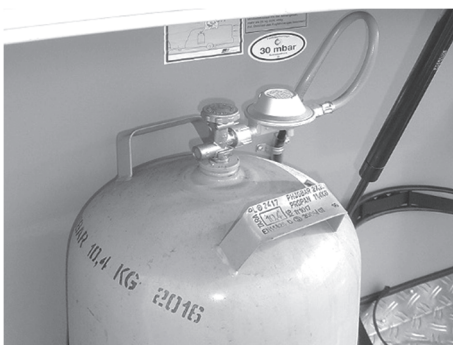
Abb. 77: Druckminderventil
