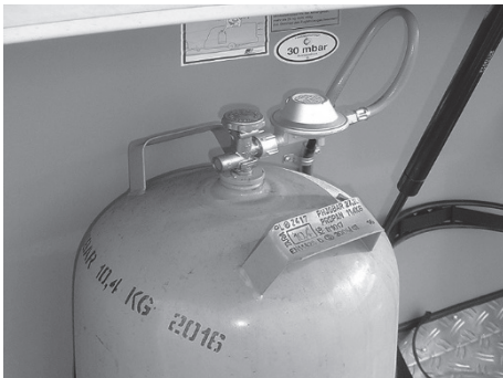
Abb. 115: Gasflasche mit Druckminderventil
