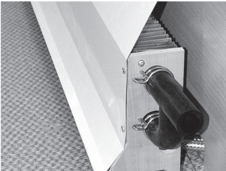
Abb. 91: Konvektor mit Wärmeleitblech
