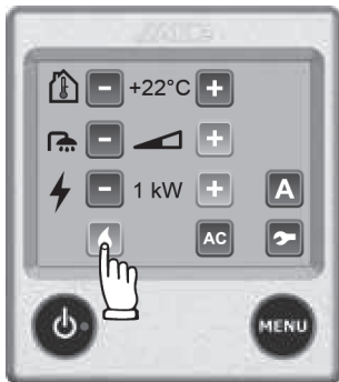
Abb. 169: Heizen mit Gas
