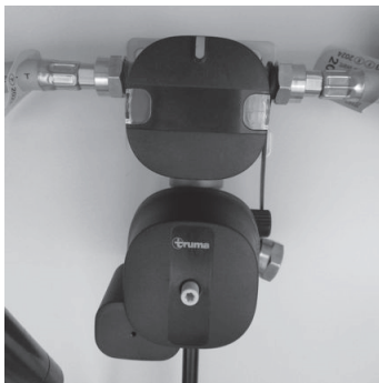
Abb. 116: Gasversorgung DuoControl CS
